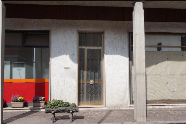
Ingresso vano scala comune da portico a sud
