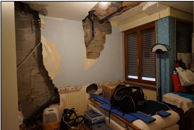
Piano primo – Camera a nord
