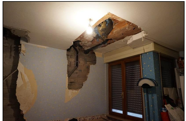
Piano primo – Camera a nord
