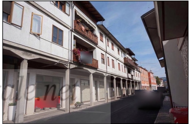
Vista da sud/ovest fabbricato
