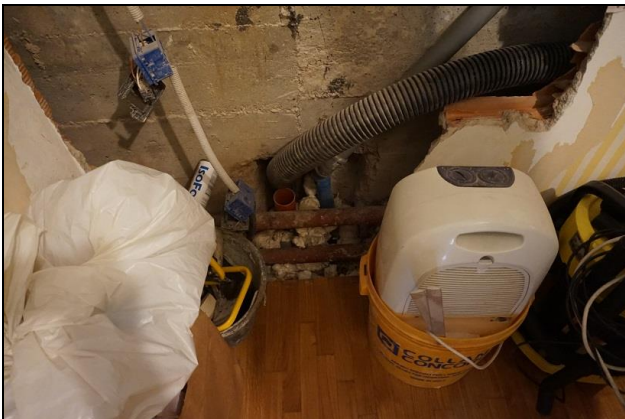
Piano primo – Lavori su camera a nord
