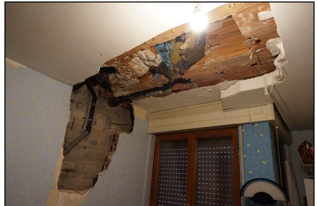
Piano primo – Camera a nord
