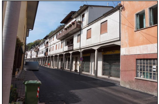
Vista da sud/est fabbricato
