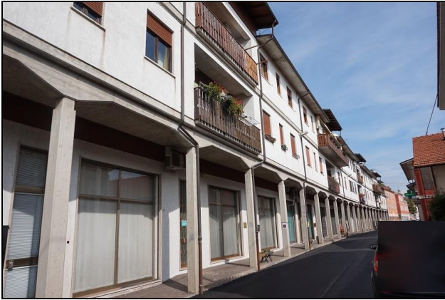
Vista da sud/ovest fabbricato
