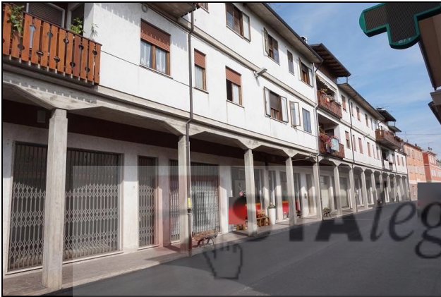
Vista da sud/ovest fabbricato
