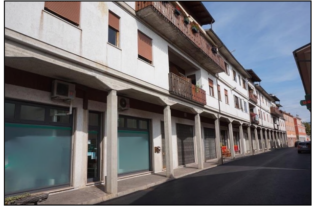
Vista da sud/ovest fabbricato
