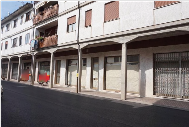
Vista da sud/est fabbricato
