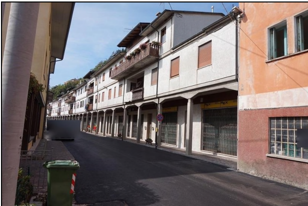
Vista da sud/est fabbricato
