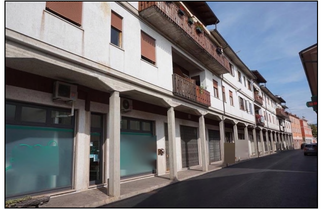
Vista da sud/ovest fabbricato
