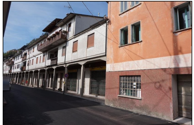
Vista da sud/est fabbricato
