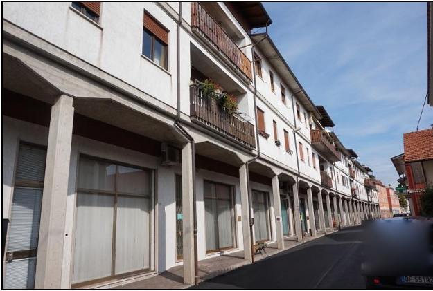
Vista da sud/ovest fabbricato
