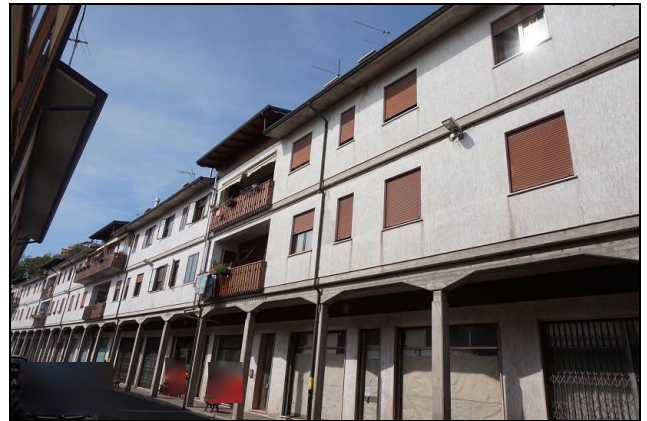
Vista da sud/est fabbricato
