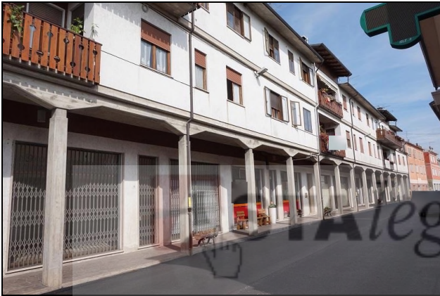
Vista da sud/ovest fabbricato
