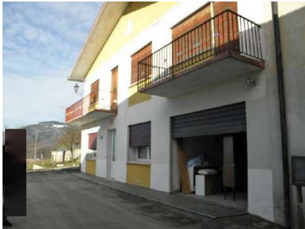
VISTA ESTERNA ABITAZIONE E AUTORIMESSA
