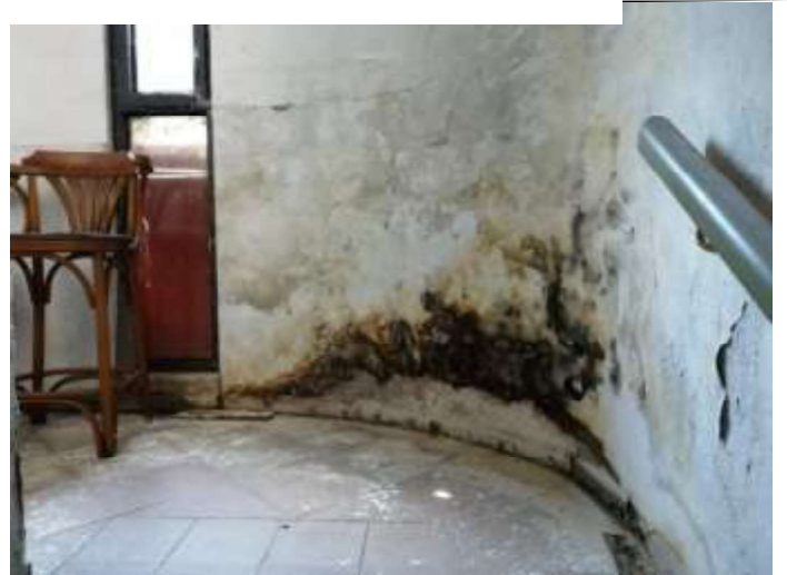
Foto 10: Infiltrazioni/muffa su scale di collegamento P-1/PT
