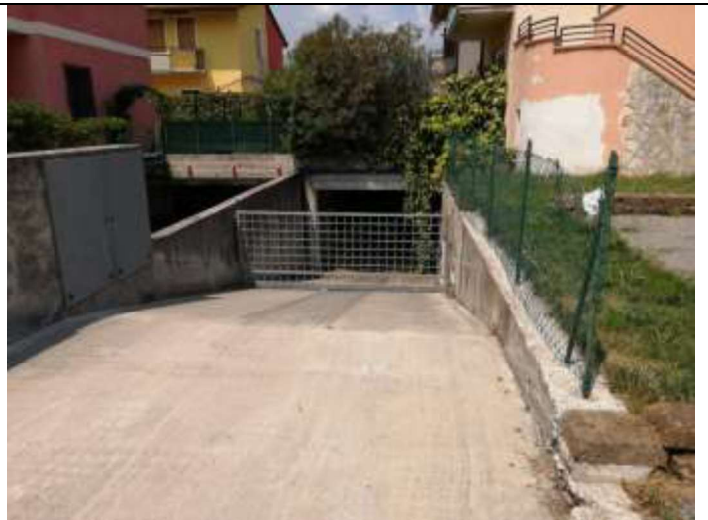
Foto 4: Rampa carrabile esterna per accesso al P-1
