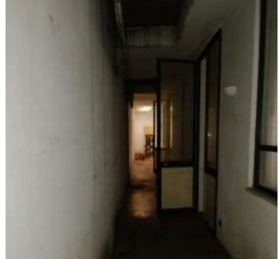
Foto 8: P-1 Trincea di aerazione
