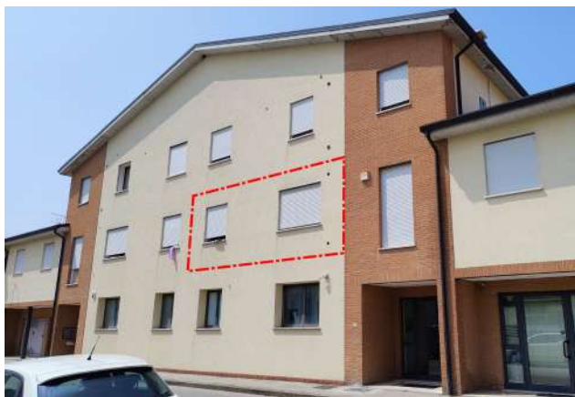
Facciata principale, con posizione appartamento
