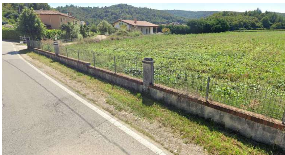
Figura 12 P.la 1031 fascia stradale
