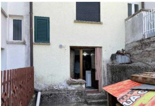
Vista della facciata posteriore
