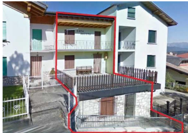
Vista del fabbricato dalla Via Ortigara
