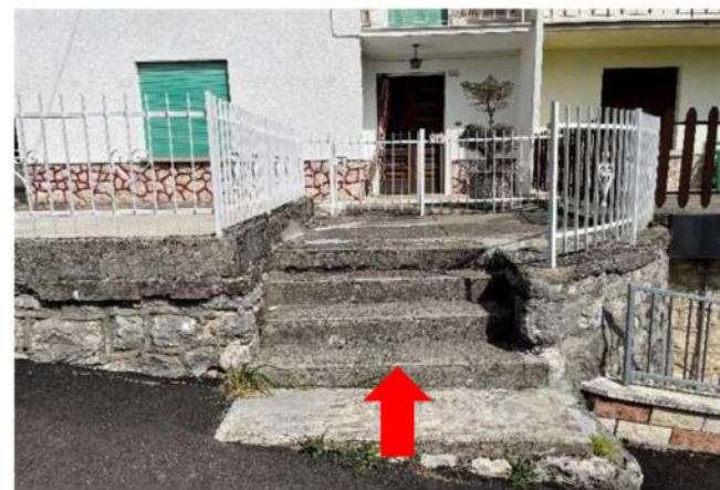
Vista dell'ingresso dal piano rialzato
