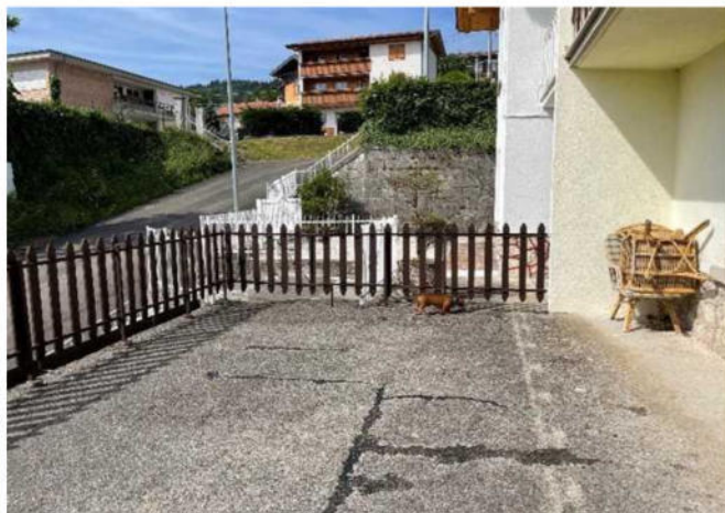
Vista della terrazza del piano rialzato
