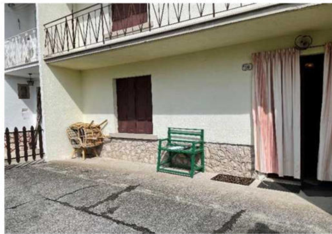
Vista della terrazza del piano rialzato di accesso all'abitazione
