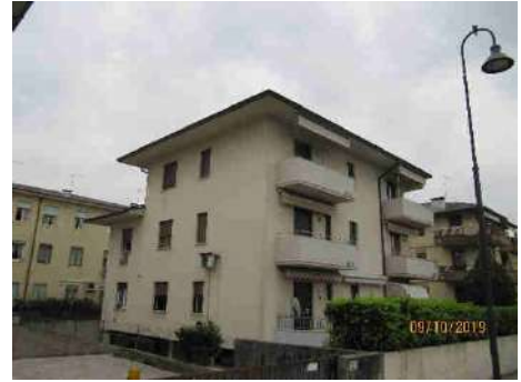
Esterno – rampa accesso garage
