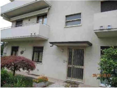
Esterno – entrata pedonale
