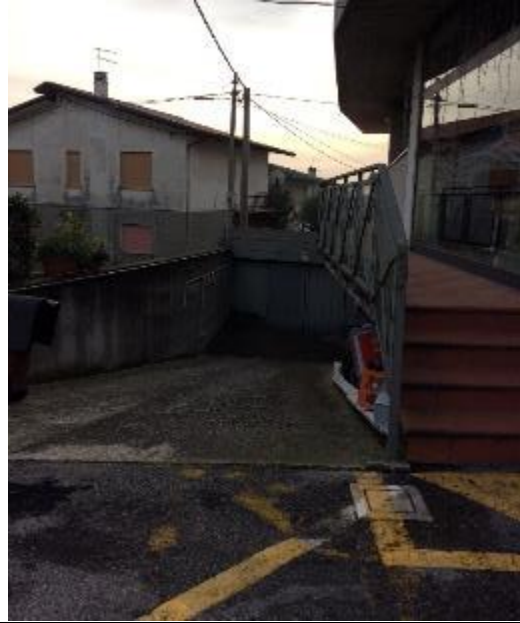
Foto 26: Vista della rampa di accesso (corte sub 15) all'autorimessa sub 10
