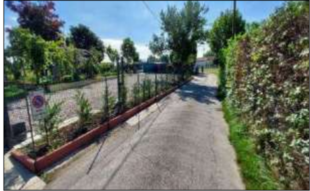
Vista esterna nord-ovest via Cà Martinati
