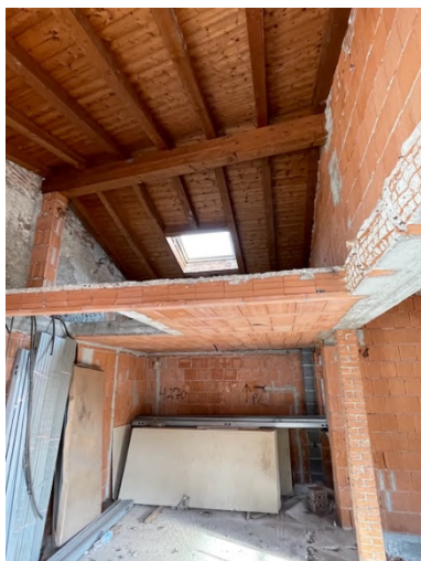
Figura 14. Foto immobile – Piano primo / secondo
