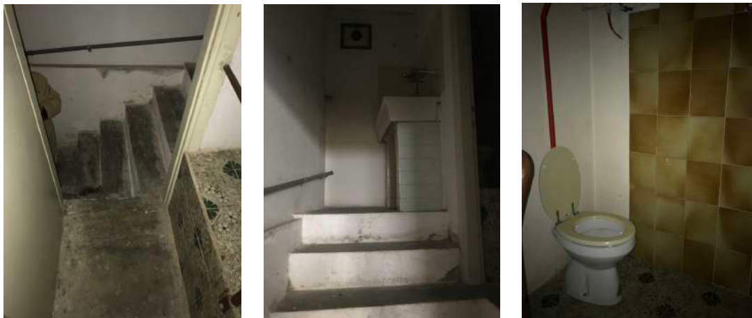
La scala che porta all'antibagno e al w.c.
