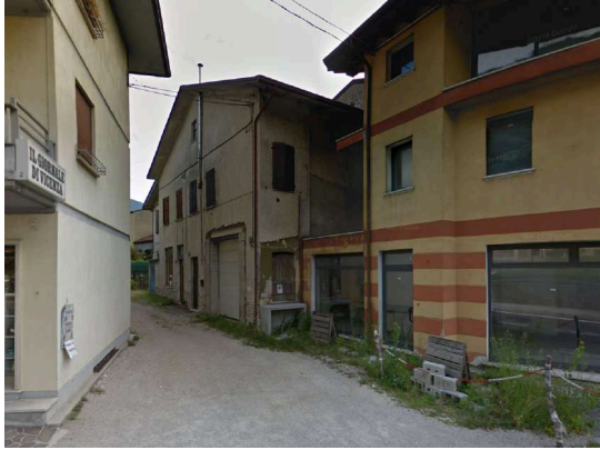
La corte di accesso da Via Rossi e la facciata principale
