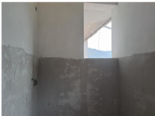
Vista del servizio igienico
