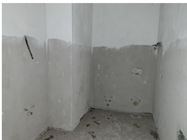
Vista del servizio igienico
