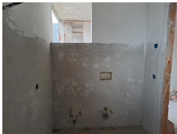
Vista del servizio igienico
