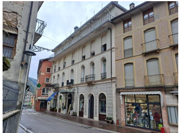
Vista generale da Nord-Ovest
