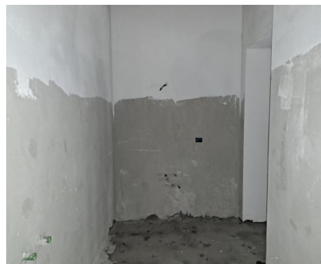
Vista del servizio igienico
