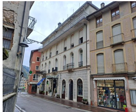
Vista generale da Nord-Ovest
