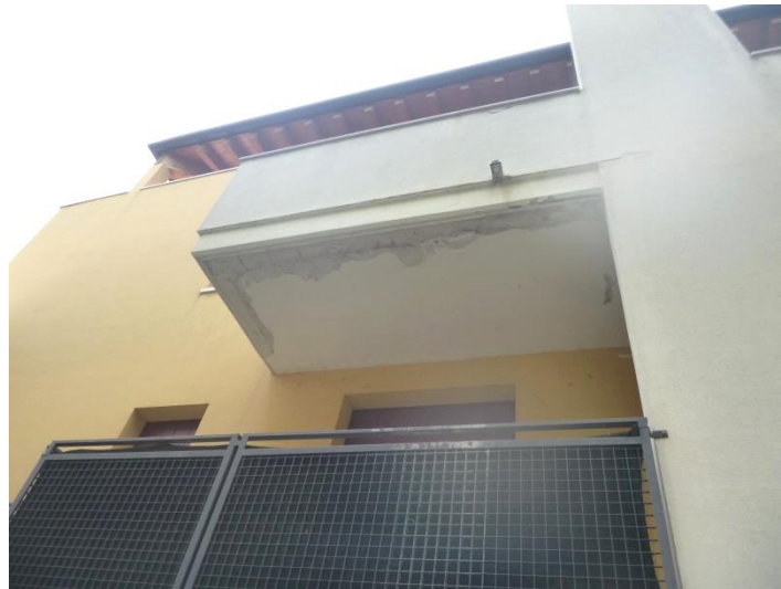
Fabbricato Fg. 18 mappale 1435 – intonaco esterno degradato nei poggiosi
