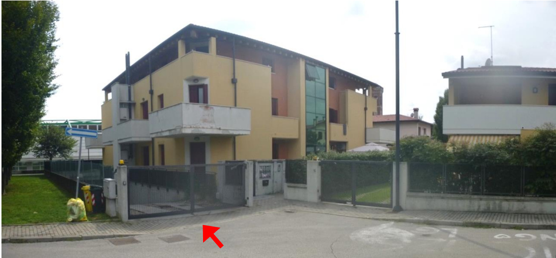
Fabbricato Fg. 18 mappale 1435 – accesso carraio lato Nord/Est fronte Via Don Martino Bassani
