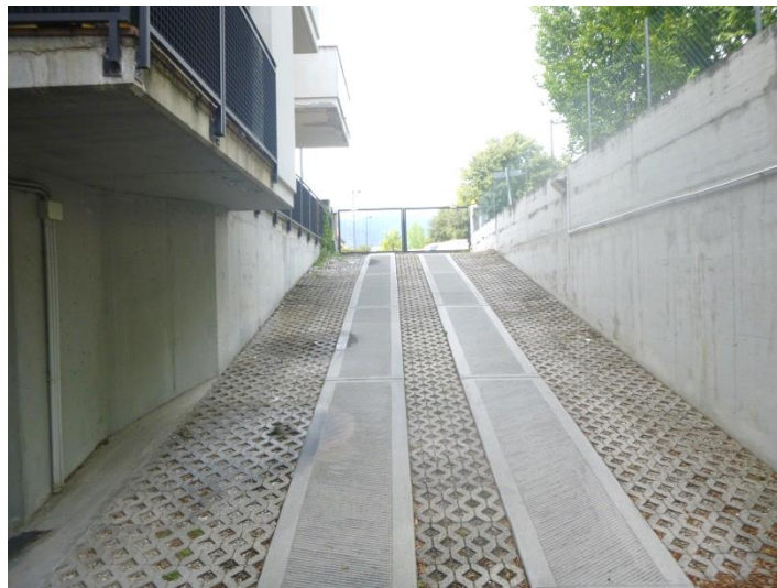
Fabbricato Fg. 18 mappale 1435 – rampa scivolo di accesso alle autorimesse
