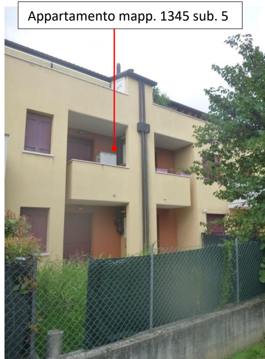
Fabbricato Fg. 18 mappale 1435 – lato Sud fronte percorso pedonale e ciclabile
