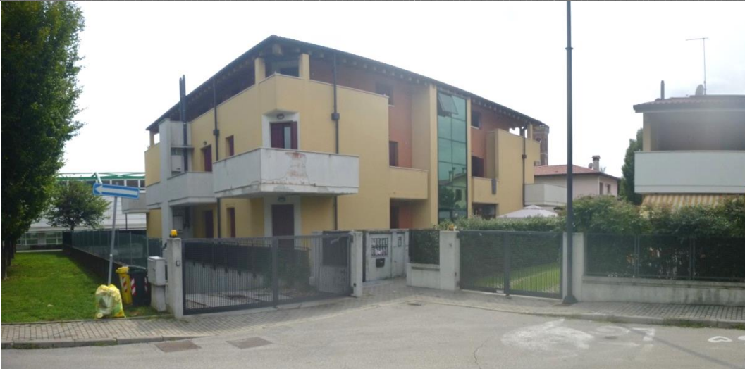
Fabbricato Fg. 18 mappale 1435 – lato Nord/Est fronte Via Don Martino Bassani
