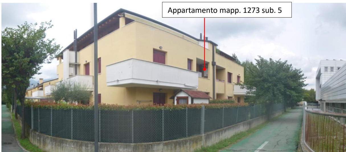
Fabbricato Fg. 18 mappale 1435 – lato Sud/Ovest fronte percorso pedonale e ciclabile
