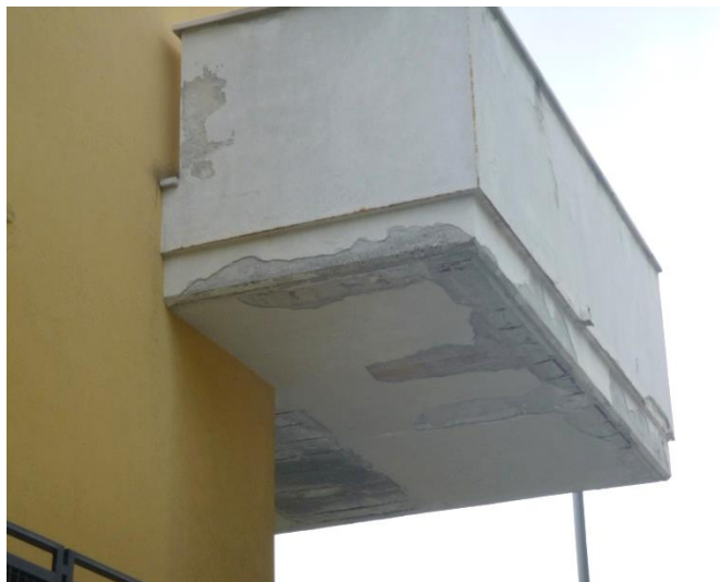
Fabbricato Fg. 18 mappale 1435 – intonaco esterno degradato nei poggiosi
