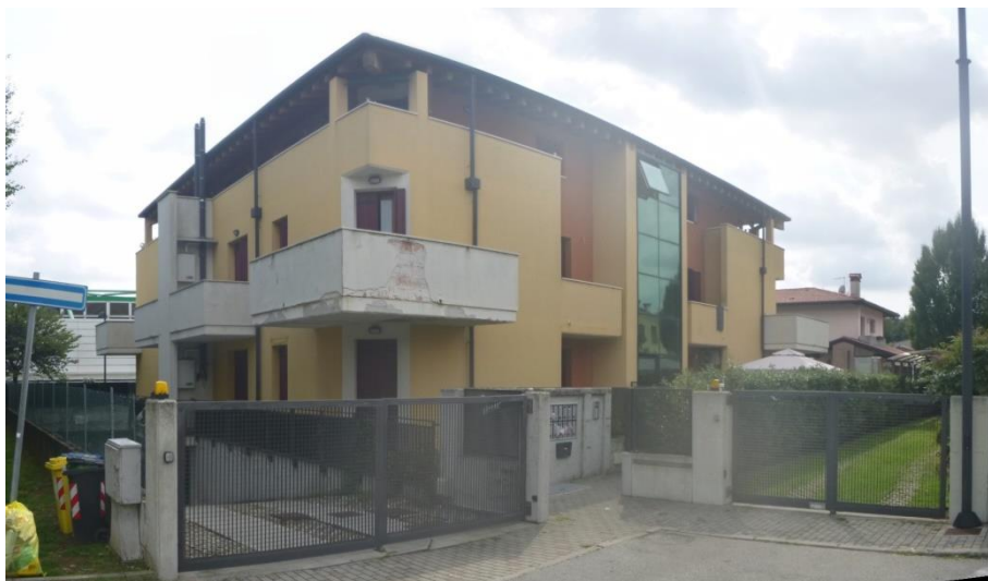
Fabbricato Fg. 18 mappale 1435 – lato Nord/Est fronte Via Don Martino Bassani
