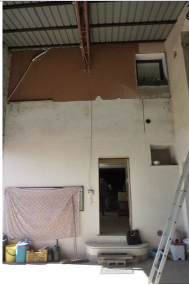
ingresso dal sottoportico
