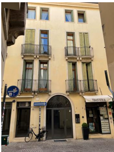
veduta ingresso fabbricato
