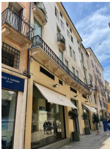
veduta retro fabbricato su Contrà Cavour
