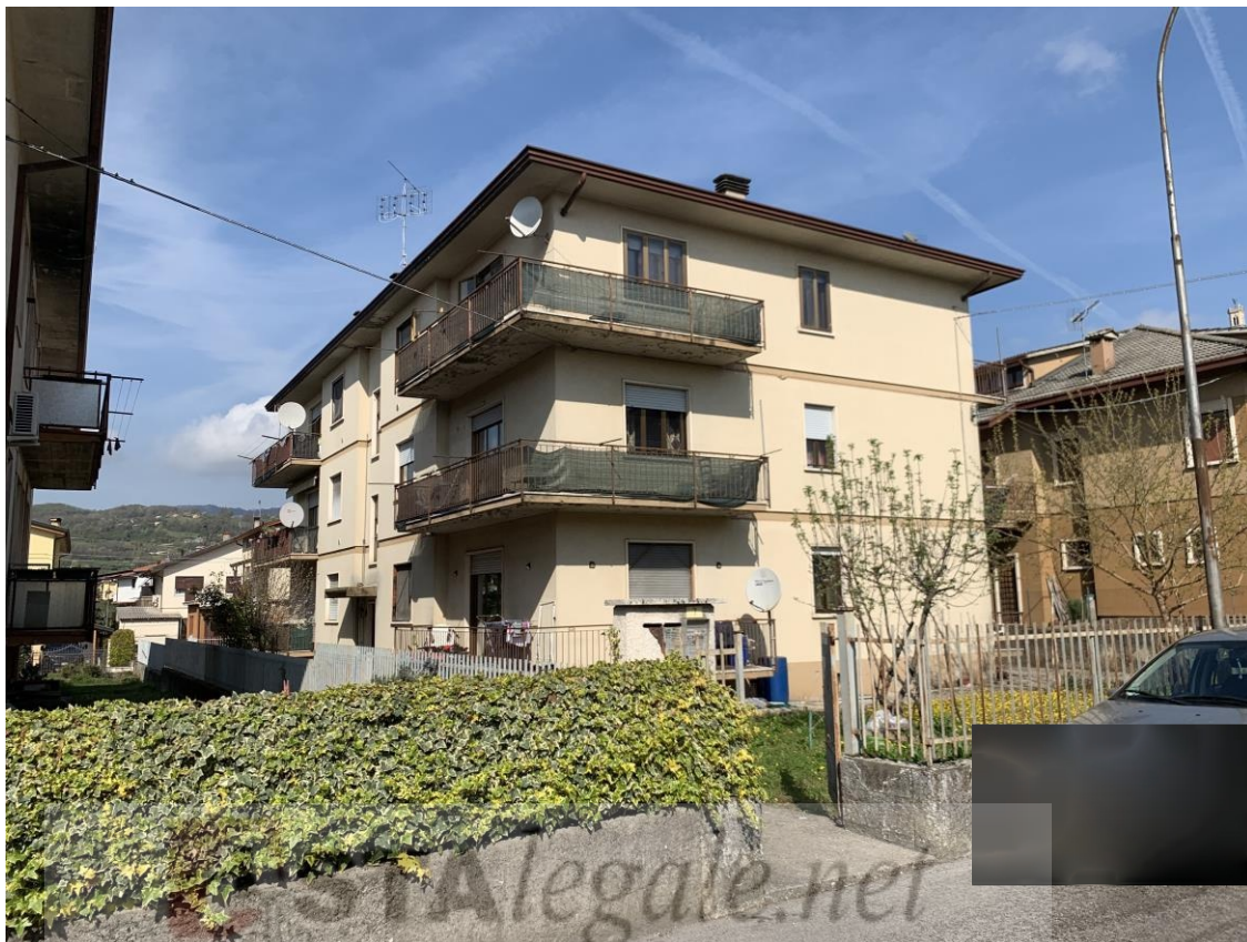
Foto n 1 – fabbricato plurifamigliare
