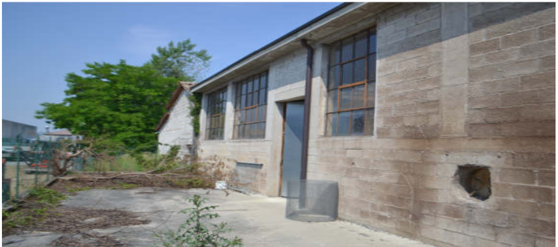
Prospetto -retro dell'edificio con area cortilizia esterna
