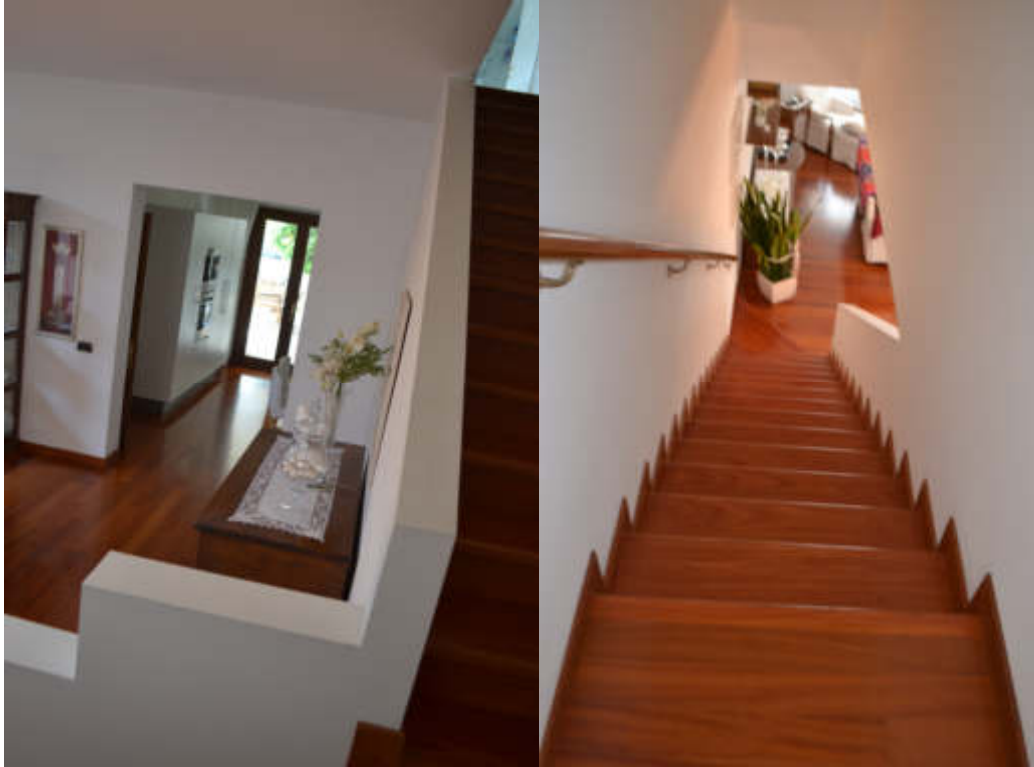
Scala di collegamento tra piano terra-zona giorno e piano primo-zona notte La scala realizzata in cemento armato e rivestita in legno.
