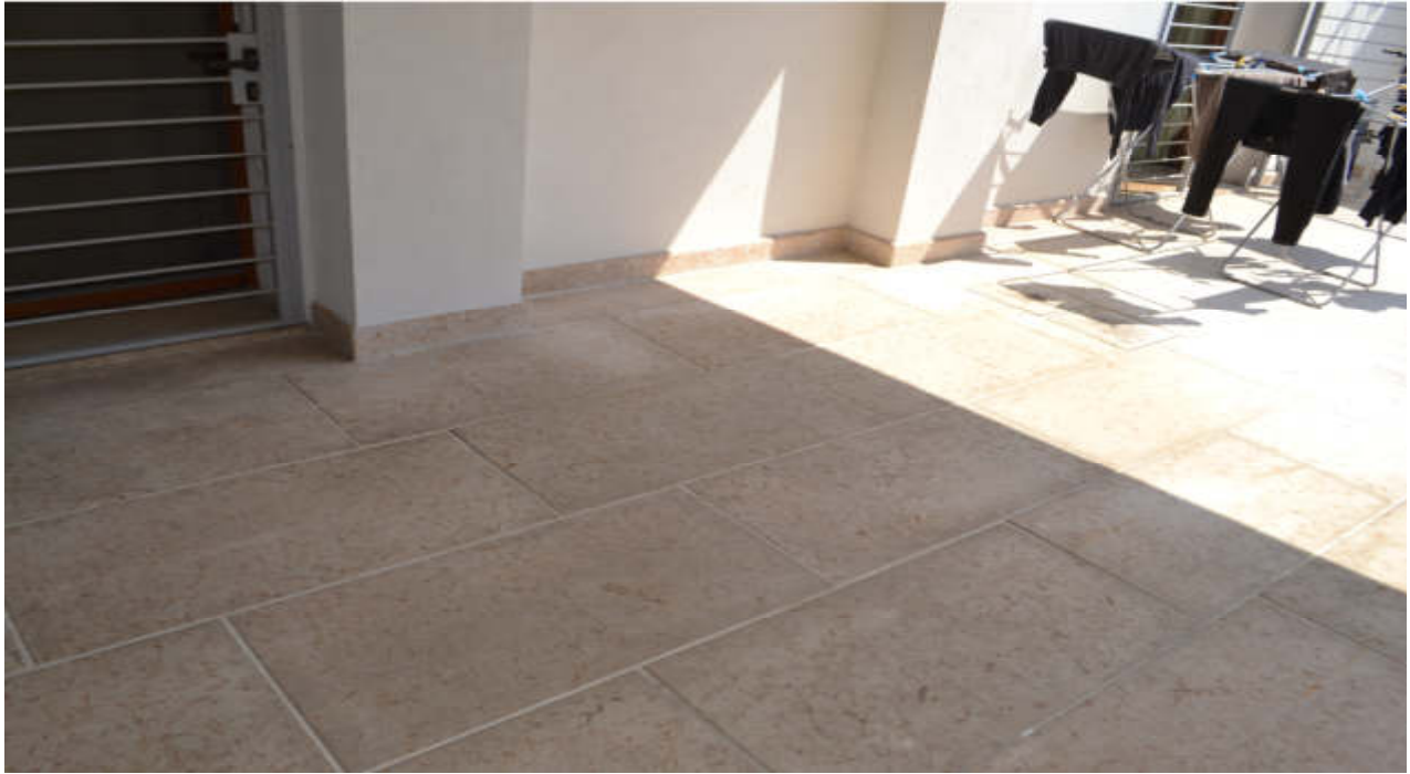
Piano seminterrato: Pavimentazione esterna realizzata in lastroni di marmo Rosa Asiago.
