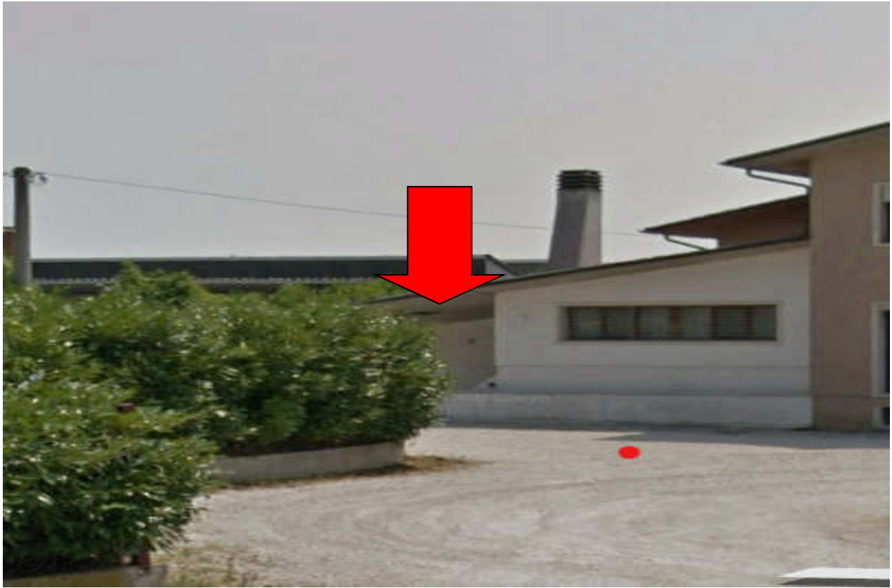
1- Piano terra: ingresso principale
