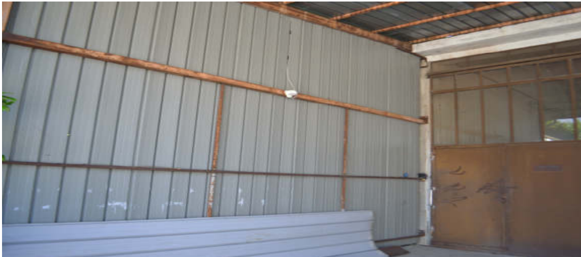
Tamponamento laterale tettoia e dettaglio portone d'ingresso
