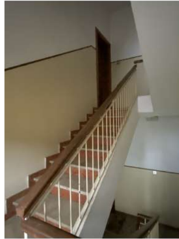
Vista vano scala comune
