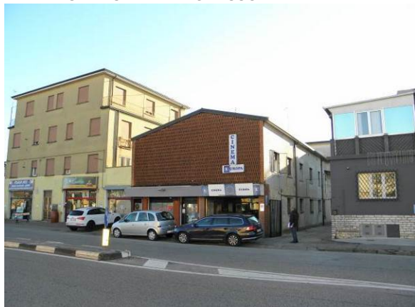
VISTA ESTERNA INGRESSO VIALE DELLA PACE
