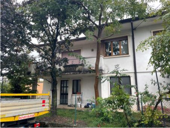
Esterno: vista Nord
