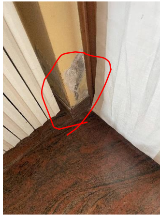
particolari infiltrazioni: cucina piedi murature - soffitto soggiorno P.1
