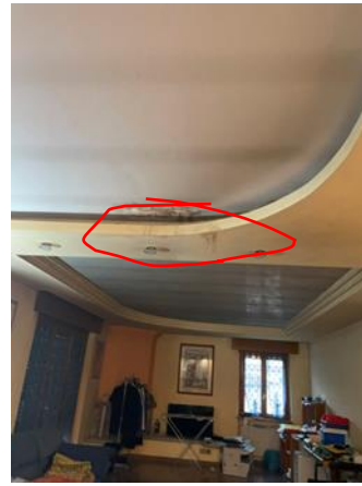
particolari infiltrazioni: cucina piedi murature - soffitto soggiorno P.1
