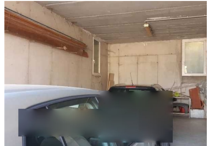
Vista dell'autorimessa al p. S1
