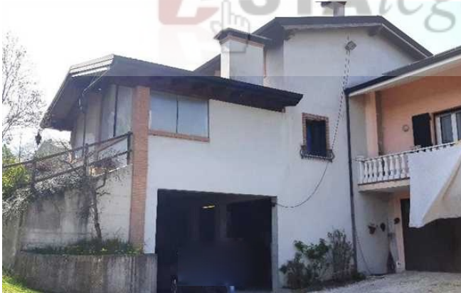
Vista del fabbricato da Sud Est
