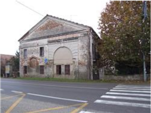
Veduta del compendio immobiliare da Ovest
