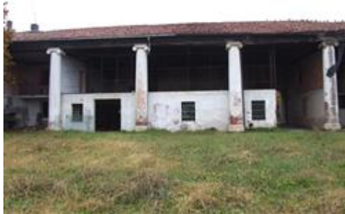
Veduta del Corpo E
