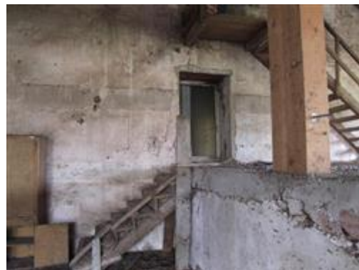
Accesso alla soffitta
