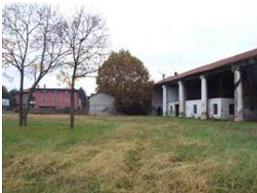
Veduta del Corpo H - area strettamente pertinenziale del compendio
