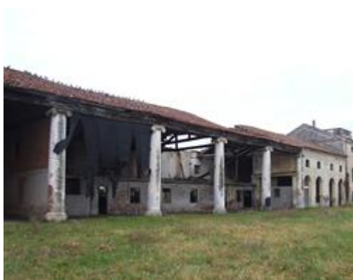
Veduta del Corpo A
