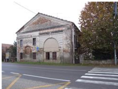
Veduta del compendio immobiliare da Ovest
