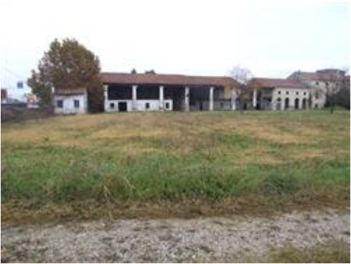
Veduta del compendio immobiliare da Sud
