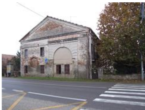
Veduta del compendio immobiliare da Ovest
