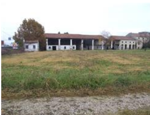
Veduta del compendio immobiliare da Sud
