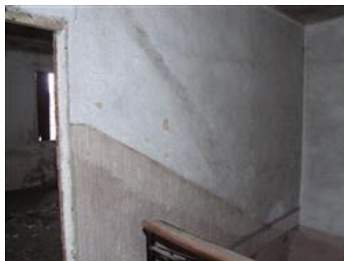
Inaccessibilità al piano secondo
