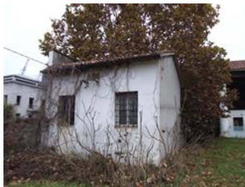
Veduta da Sud-Est del Corpo G
