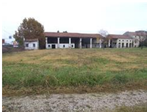
Veduta del compendio immobiliare da Sud
