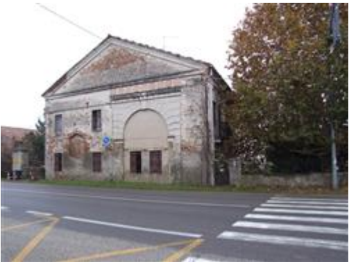
Veduta del compendio immobiliare da Ovest
