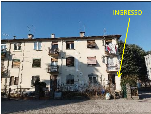
Facciata sud su Via Vittore Carpaccio
