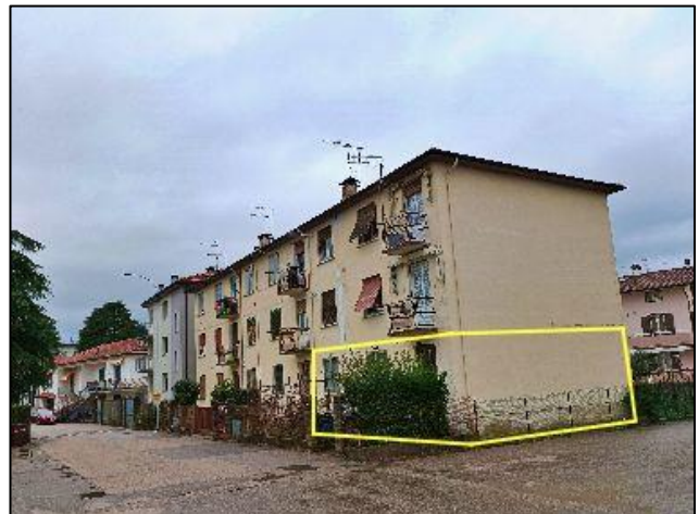
Vista angolo sud-est del caseggiato
