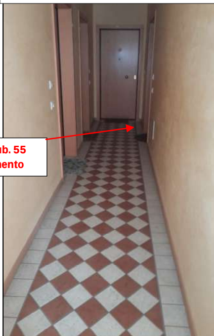
Particolare pianerottolo/ percorsi pedonali al piano 2
