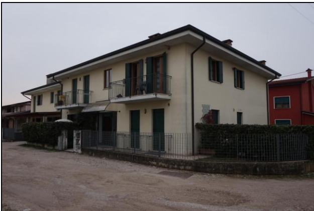
Fabbricato da nord/est
