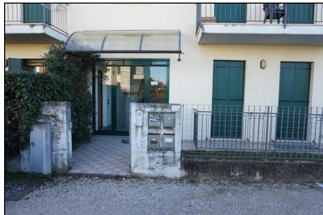
Ingresso blocco nord fronte est
