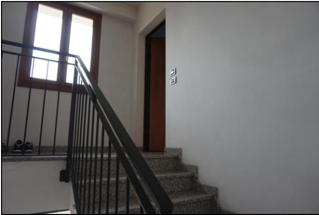
Piano primo – Portoncino ingresso appartamento
