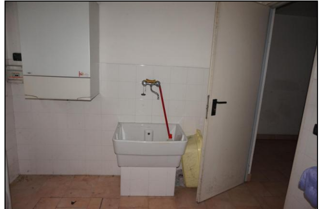
Piano interrato – Ripostiglio/C.T.
