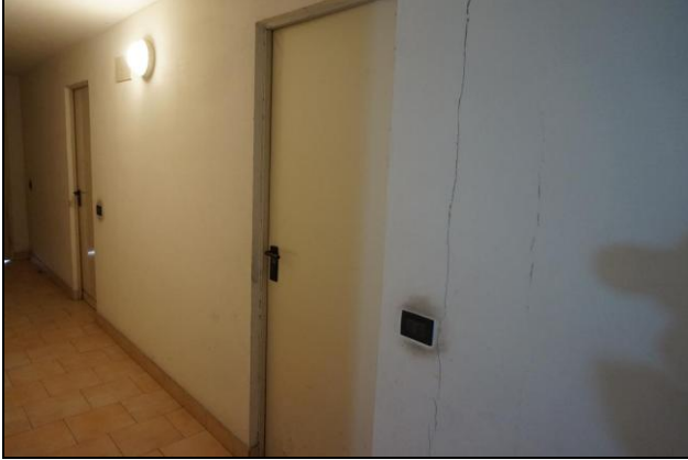
Piano interrato – Ingresso da corridoio comune
