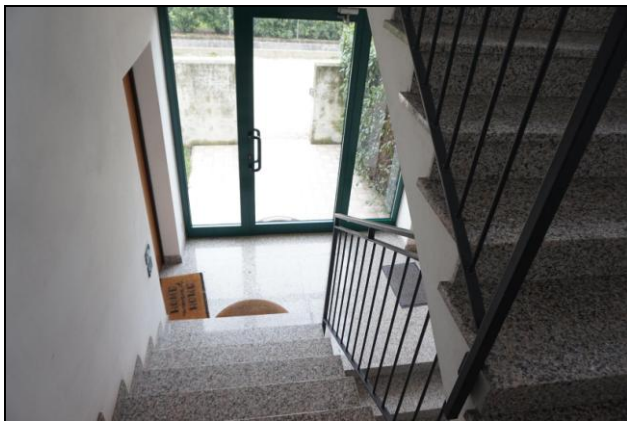
Zona ingresso vano scale
