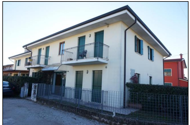
Fabbricato da nord/est
