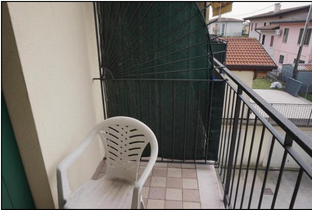
Piano primo – Poggiolo a sud/ovest
