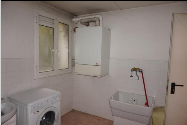
Piano interrato – Ripostiglio/C.T.
