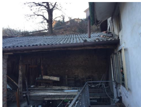
foto n. 22 – tetto in eternit portico
