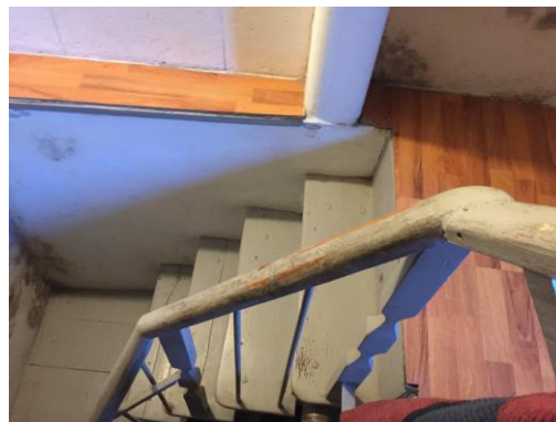
foto n. 12- SUB. 1 – vano scala
