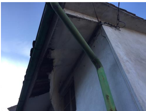
foto n. 21 –distacco intonaco
