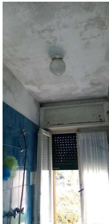
**Figura 12 locale bagno e dettaglio soffitto bagno con aree soggette a formazione di muffa**
