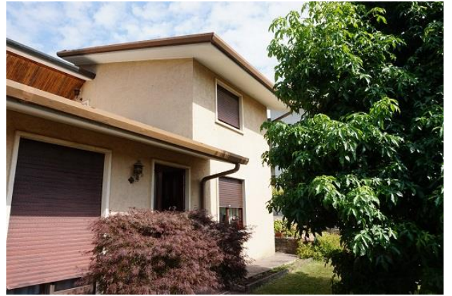
Porzione est fabbricato con ingresso abitazione
