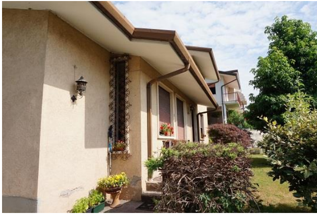
Particolare fronte est fabbricato
