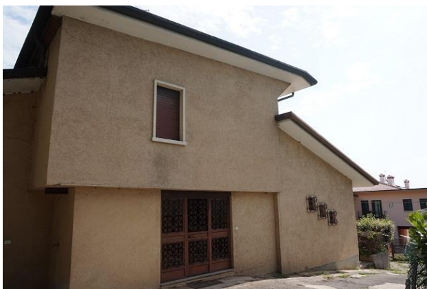
Fronte sud fabbricato da corte interna
