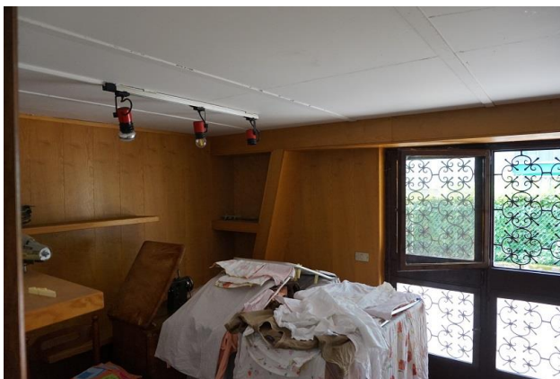
Piano terra – cantina porzione sud/est
