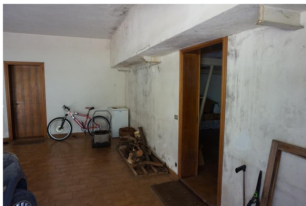
Piano terra – porta di collegamento da garage a cantina
