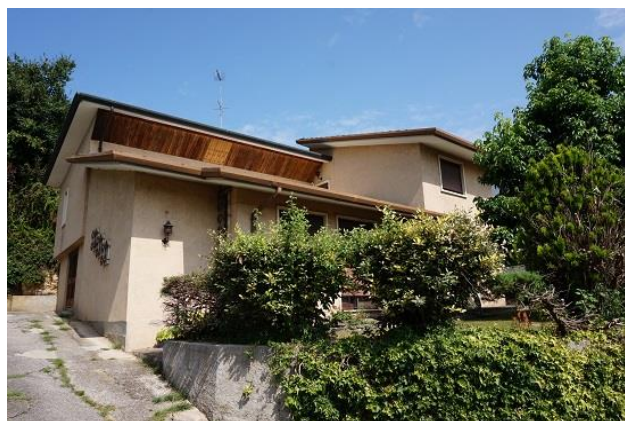
Fronti sud ed est fabbricato da corte interna
