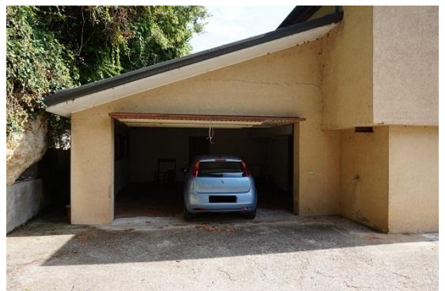
Fronte sud fabbricato lato ovest
