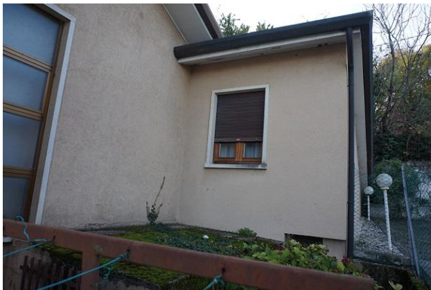
Fronti nord ed est fabbricato porzione ovest
