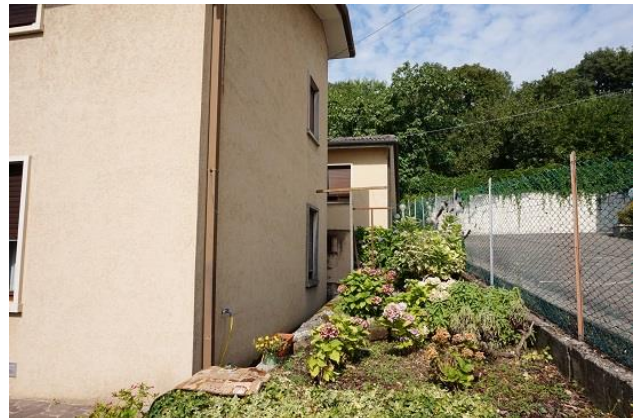
Fronte nord fabbricato da corte interna
