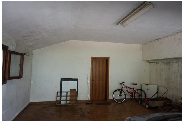
Piano terra – zona nord garage e porta collegamento taverna
