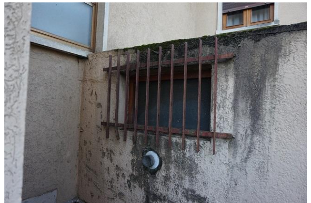
Particolare apertura su centrale termica a nord
