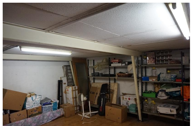
Piano terra – particolare struttura e soffitto cantina
