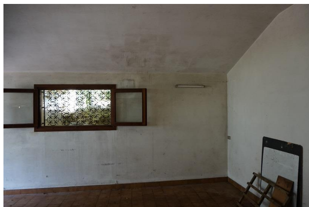
Piano terra – parete ovest garage con affaccio su terreno roccioso
