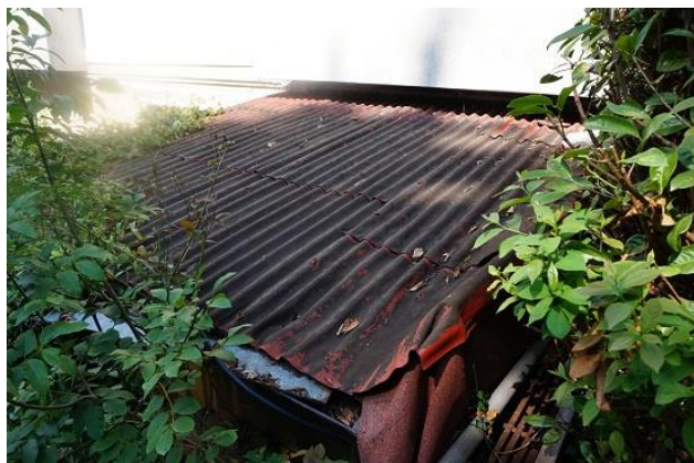
Tettoia angolo nord/est piano seminterrato
