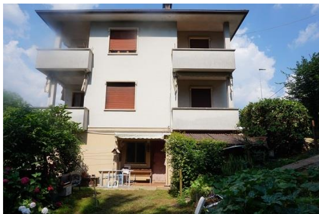
Vista da est con accesso locali seminterrato
