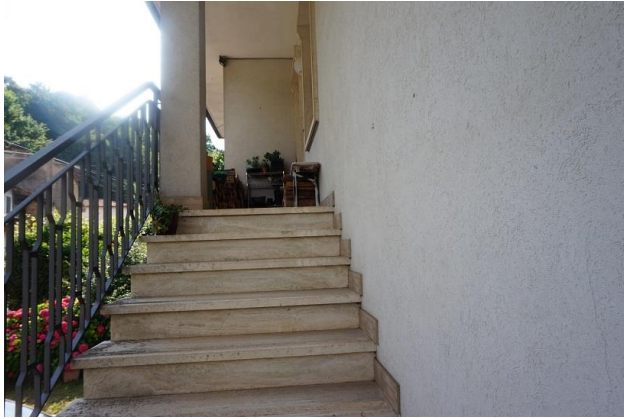
Scala esterna accesso piano primo da ovest verso est
