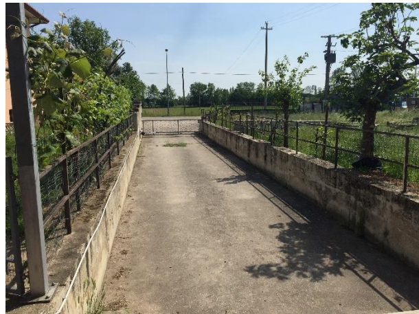
- rampa vista lato capannone
