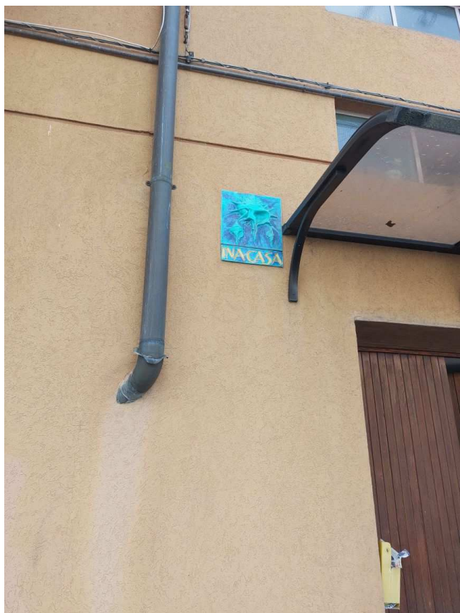
Targhetta INA CASA sul portoncino di ingresso condominiale
