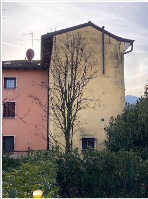
Vista prospetto nord-est dell'edificio
