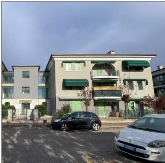
La palazzina - frontestrada
