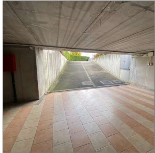
Rampa di accesso alle autorimesse interrattate
