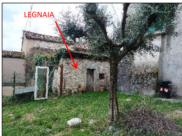
Legnaia con accesso dalla corte di proprietà
