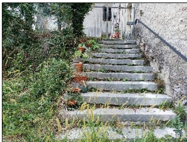
Scalinata sull'area scoperta di proprietà
