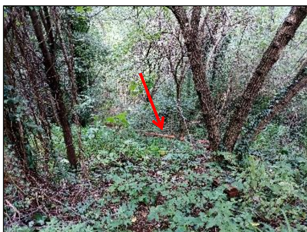
Tubazione di scarico all'interno del terreno
