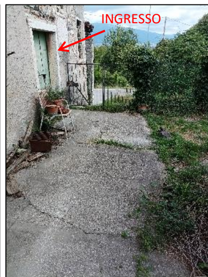
Portoncino di ingresso su facciata sud
