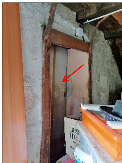
Porta di collegamento con l'abitazione
