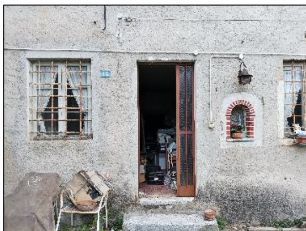
Portoncino di ingresso su facciata sud
