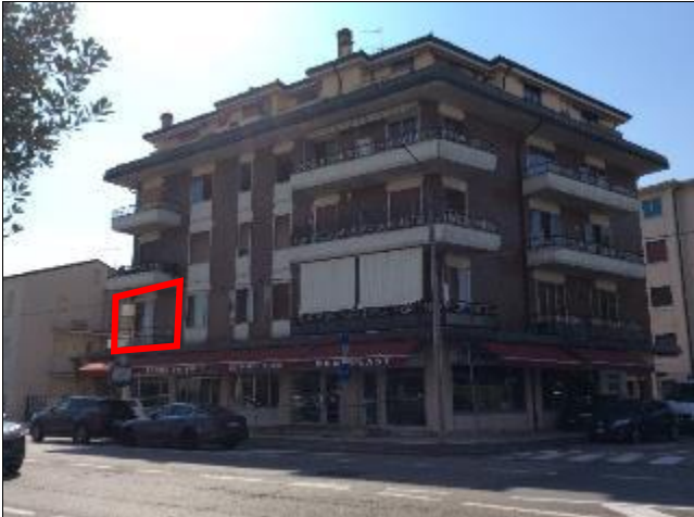
Foto 1: Esterni fabbricato: in rosso appart. P1
