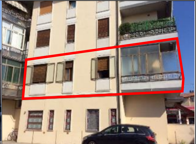
Foto 2: Esterni fabbricato: in rosso appart. P1
