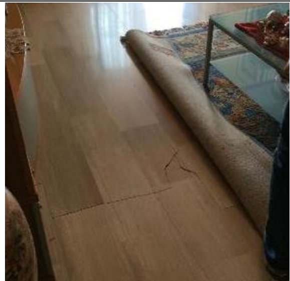
Foto 10: Particolari pavimenti-fessure
