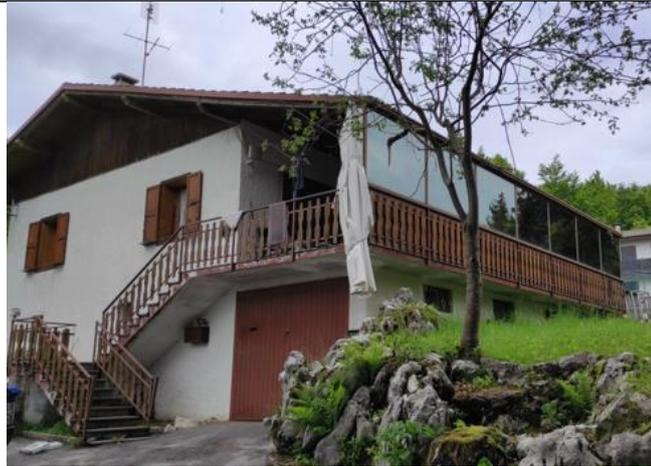
Portoncino d'ingresso è un balcone a doppia anta in legno con ferramenta metallica, come i balconi delle finestre; la pavimentazione della terrazza/portico è in Klinker e la copertura in andamento e in travi di legno con perline
