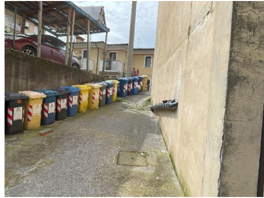
Foto 4 - Veduta rampa di accesso
