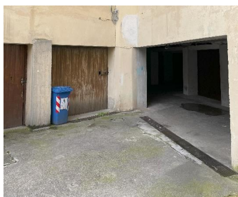
Foto 14 - PINT. – ingresso alle autorimesse
