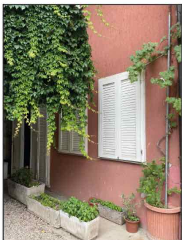
porta finestra su corte comune
