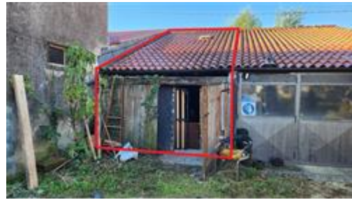
Vista esterna autorimessa
