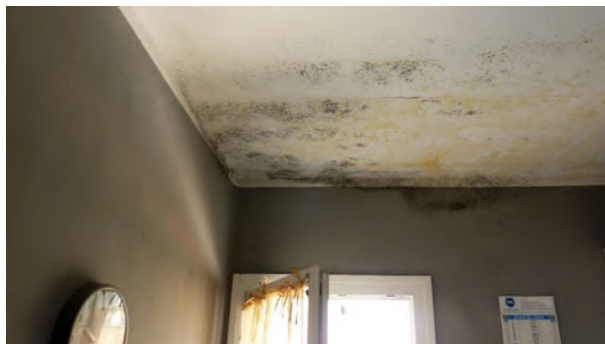
VISTA SOFFITTO CUCINA
