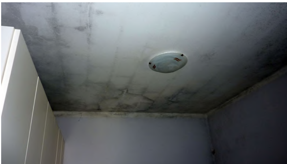
Vista intero ambiente (soffitto camera)
