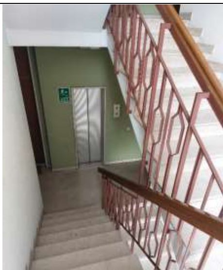
Foto 3: Vano scale e ascensore comuni
