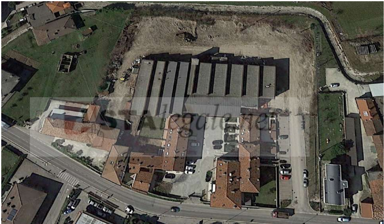
Figura 52 – Immagine DA SATELLITE dell'area al 12/03/2015 durante la fase di rimozione rifiuti
