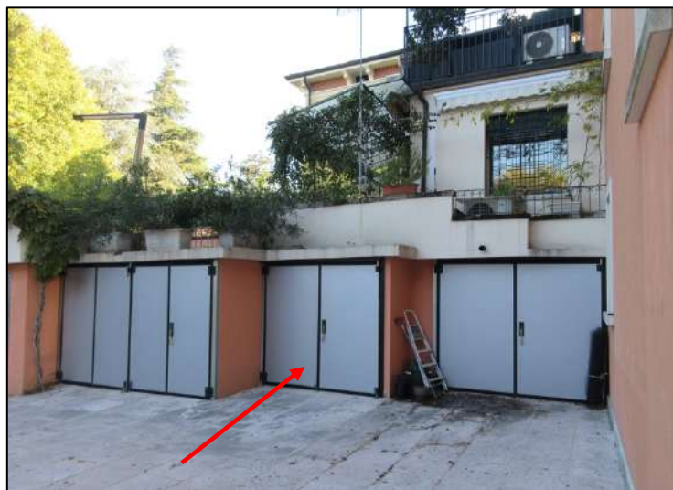
foto dell'autorimessa dal cortile interno
