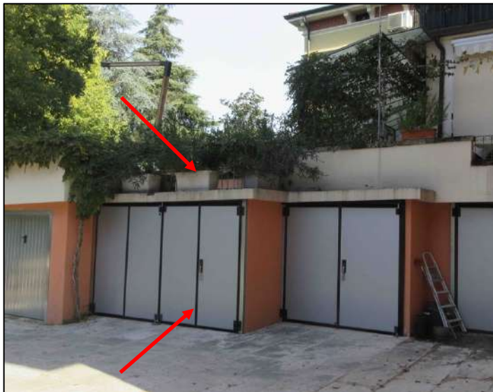
esterno autorimessa e lastrico solare
