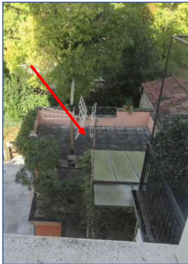
lastrico solare sub 19
