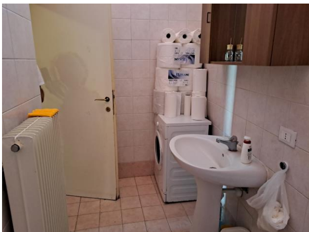
Vista del servizio igienico
