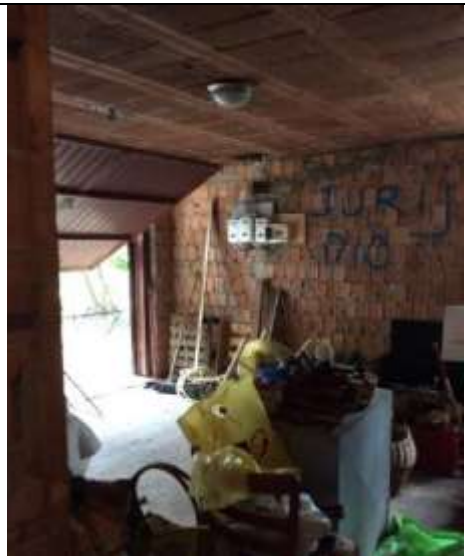
Foto 12: PT - Garage (sub 2)
