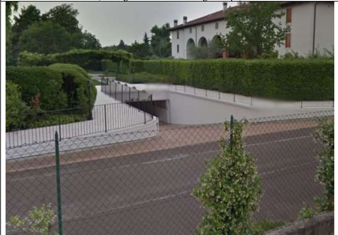
Rampa per l'accesso al garage all'interno del complesso condominiale (Immagine estratta da Google Maps)
