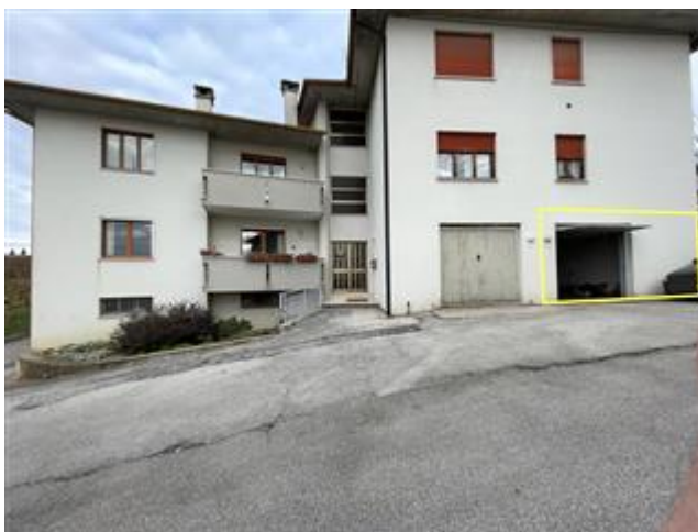
Vista esterna da sud (contorni indicativi sull'autorimessa sub. 6).
